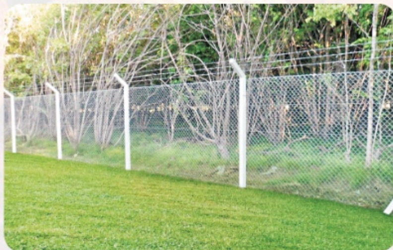
Foto 6. Protección con malla olímpica en un vivero permanente
