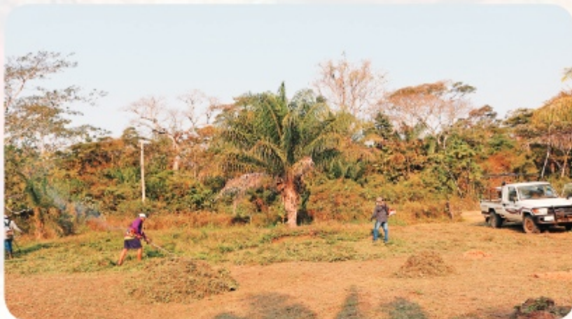
Foto 3. Limpieza del área para la instalación del vivero
