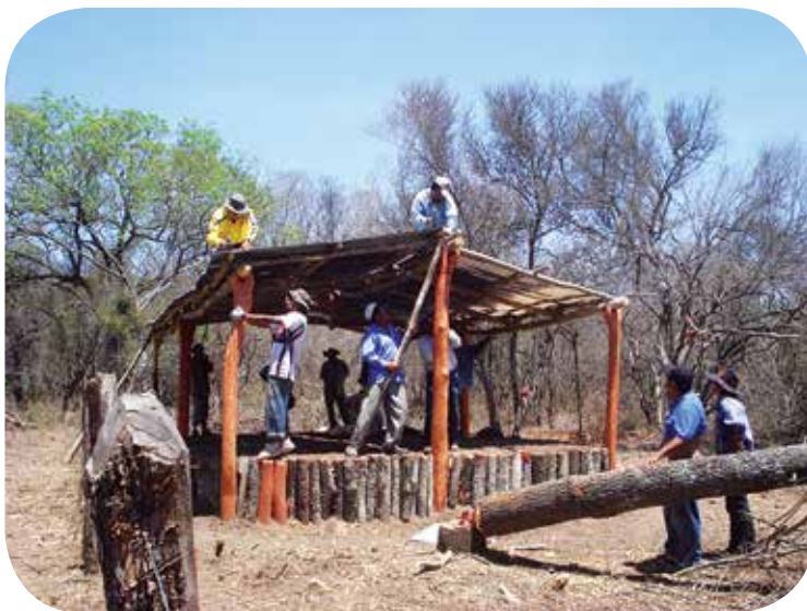
Foto 13. Construcción de infraestructura para cosecha de agua, 2009.
