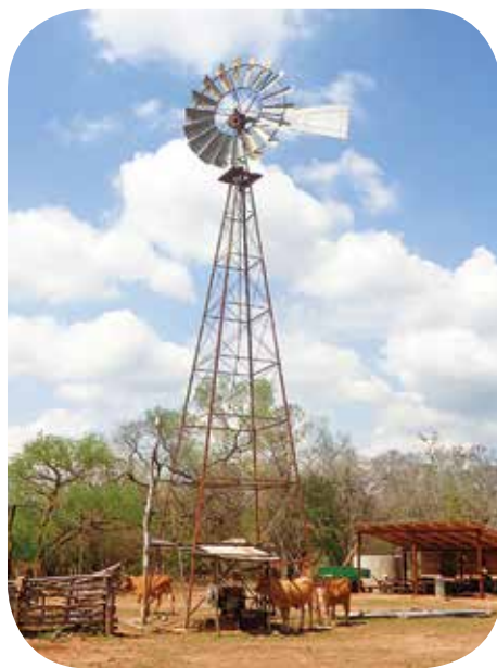
Foto 9. Aeromotor del pozo perforado y tanque de agua de la comunidad San Francisco, 2014.
