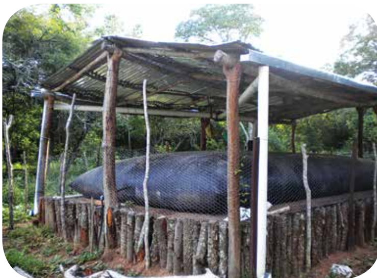
Foto 14. Cosecha de agua en aljibe geomembrana, 2009.
